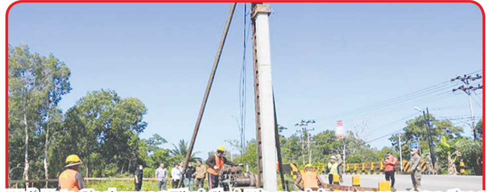
Wali Kota Singkawang Tjhai Chui Mie meninjau pemancangan tiang pertama pembangunan gerbang Cap Go Meh Singkawang.
